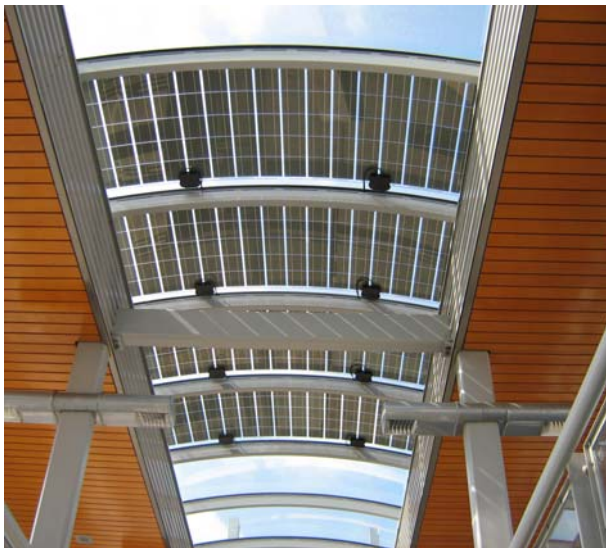
Figuur 6 Koud gebogen gelaagd glas met zonnecellen
